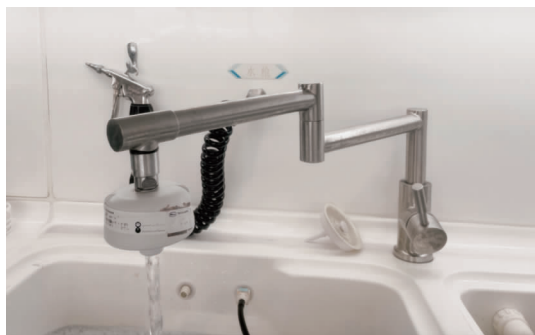
图 1 内镜终末漂洗用水水龙头终端点过滤器安装现场图
